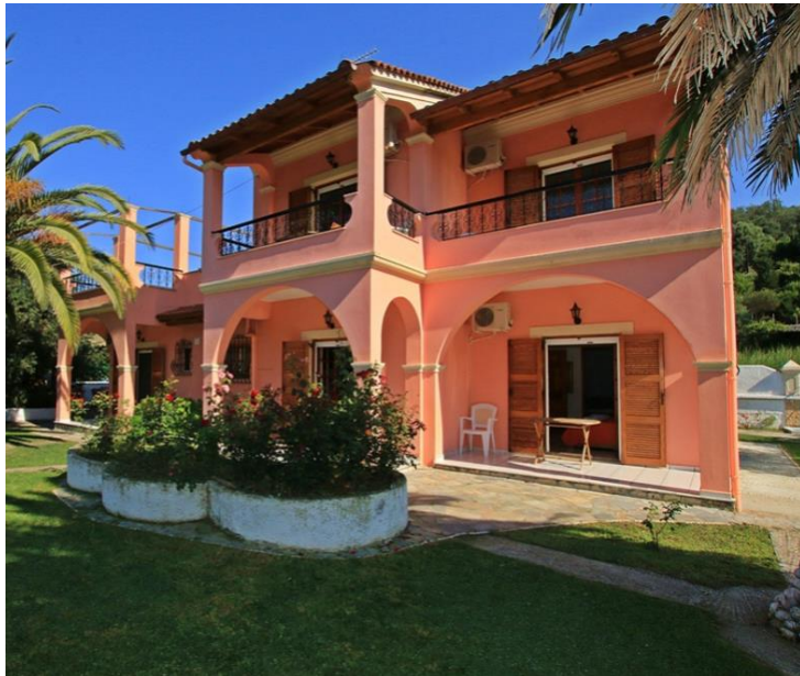
Kleines Poolhaus - Außen
